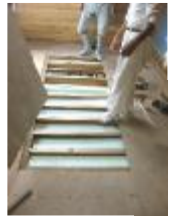
断熱材は幅に合わせて入れ直します!
