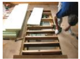
断熱材は幅に合わせて入れ直します!
