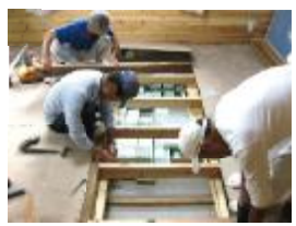
断熱材は幅に合わせて入れ直します!
