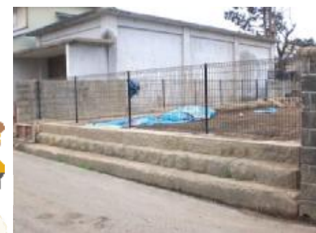
基礎だけを残して、内側に新たにフェンスを設置しました。★
