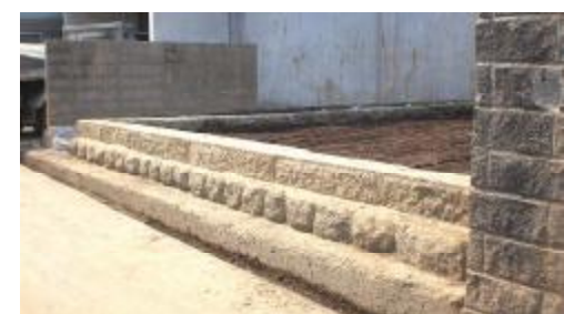
↑切り石積みの基礎があらわれました。
